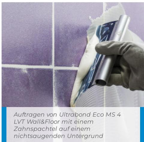
Auftragen von Ultrabond Eco MS 4 LVT Wall&Floor mit einem Zahnpachtel auf einem nichtsaugenden Untergrund
