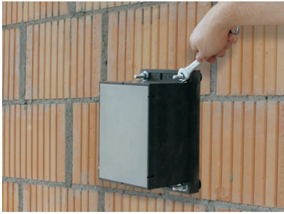
Versetzen der Universalmontageplatte UMP®-ALU-TR.
