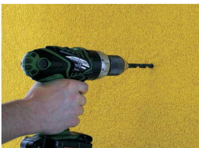
Bohrloch durch die Compact- und Aluplatte bohren.
